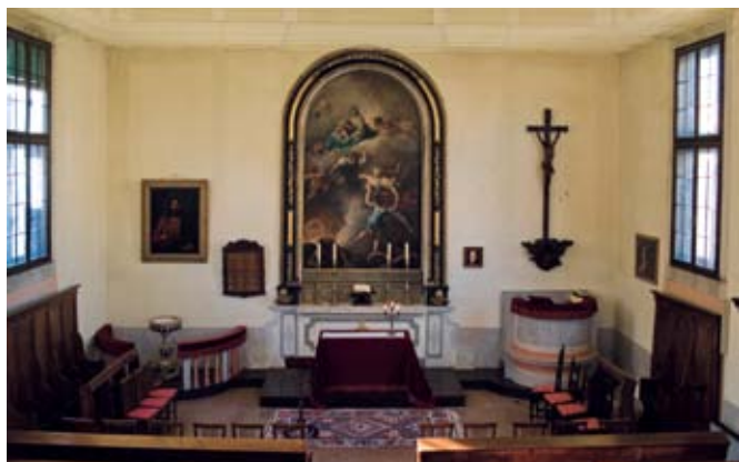
Der Kirchraum mit Netz – Schutz vor herabstürzenden Stücken/L'interno della chiesa con rete – Protezione dai pezzi che cadono dal soffitto
